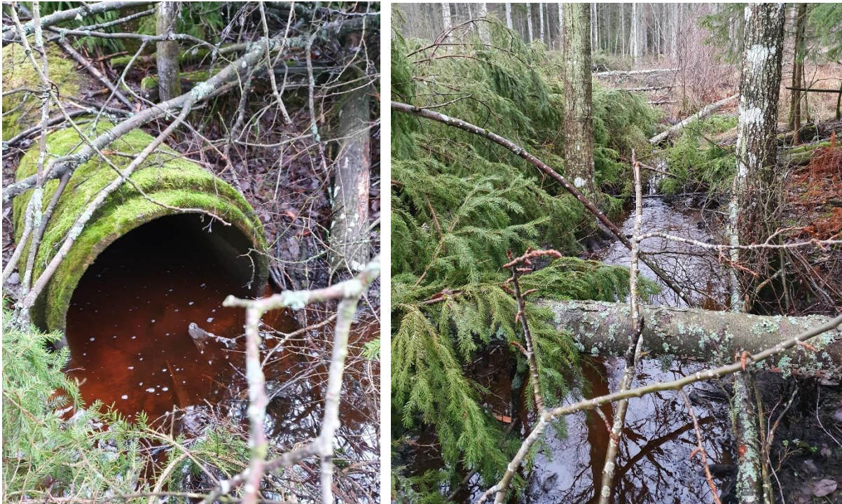
Figur 10. Kulverten (t.v.) som leder ut dagvatten från Berga industriområde till vattendraget (t.h.).
